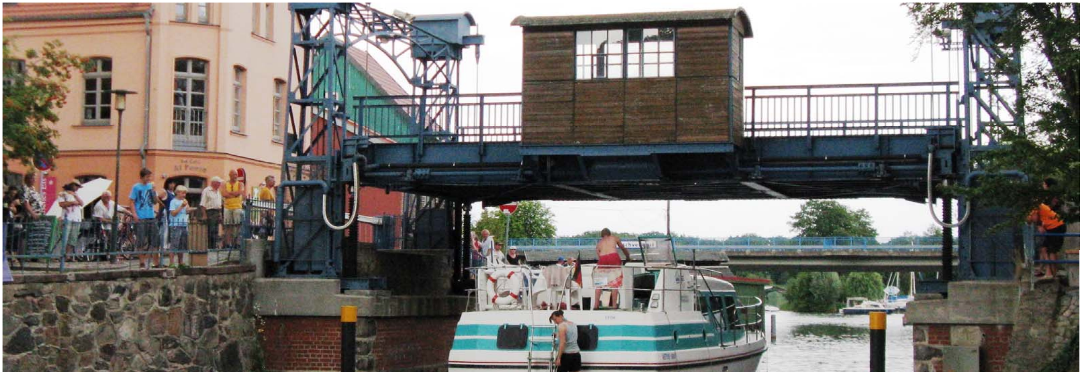
Das alte Brücken-Ding hat's in sich: abgesenkt passieren die Autos oben drüber - hochgefahren können auch die größeren Hausboote unten durch!
