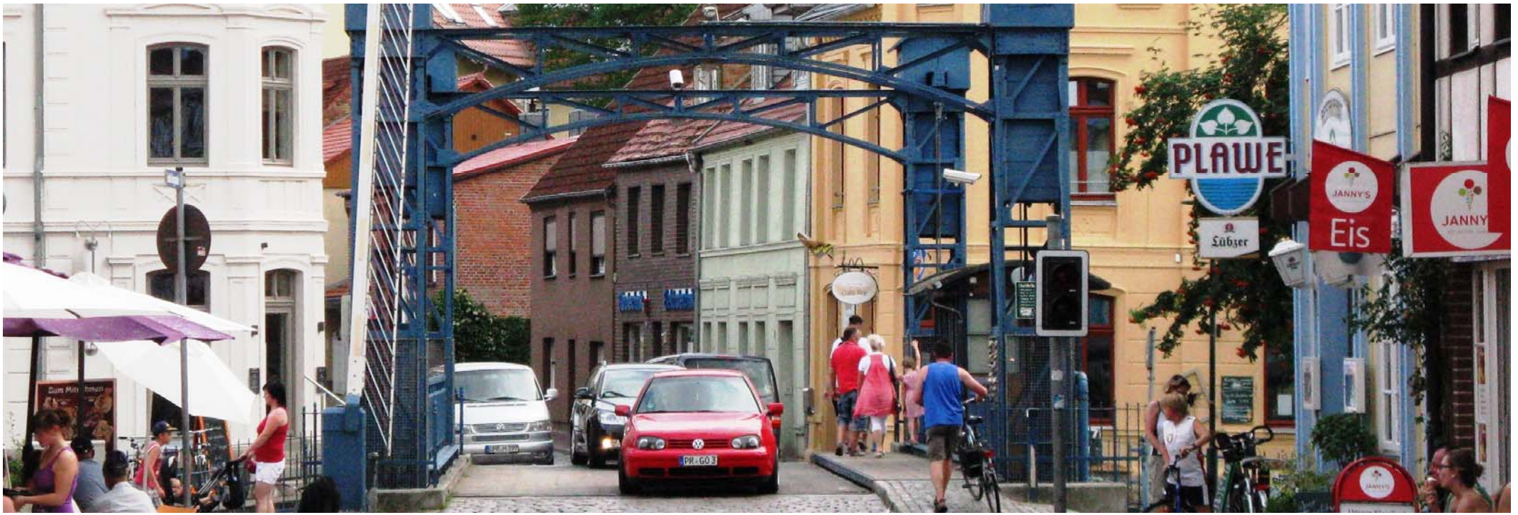
Das alte Brücken-Ding hat's in sich: abgesenkt passieren die Autos oben drüber - hochgefahren können auch die größeren Hausboote unten durch!
